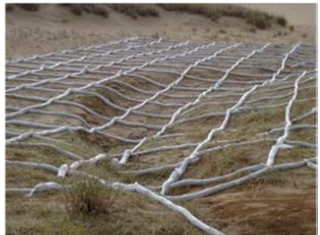
図2 火山灰露出地上に格子状に敷設されたサンドソーセージ(奥村, 2010)
