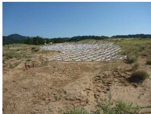
図8 トラス型サンドソーセージの設置状況 写真手前側は覆砂のみの区間, 2011.09.07撮影
