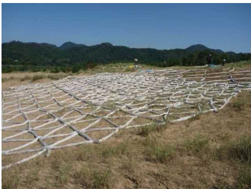
図7 3種類の大きさのトラス型サンドソーセージ 設置状況 2011.09.07撮影
