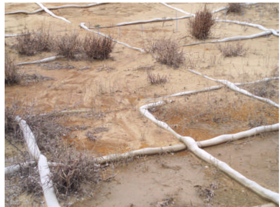
写真 5 - 12 I 区 下部 1 m 格子、2m 格子接合部 サンドソーセージが火山灰の流出を阻止している
