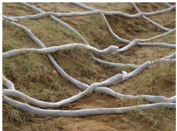
写真5-10 II区1m格子と2m格子のつなぎ ガリ状になっている
