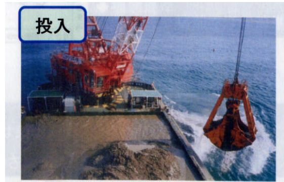
図-5(b) 土砂投入(海上)の様子
