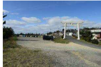
◆駐車場(湯山)の再整備
