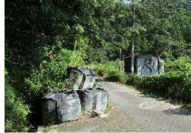
写真16: 大型土嚢による崩落対応
