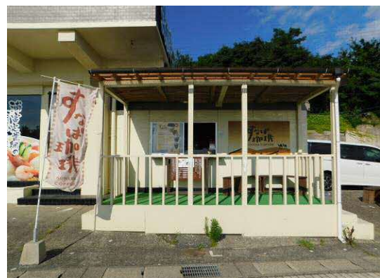
建物の外構部前面に個別に設置された休憩設備
