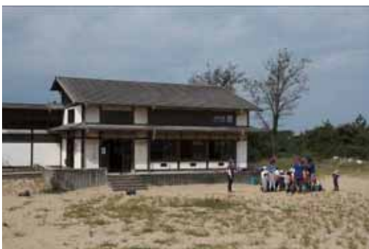
砂丘に面した休憩舎と周囲の砂丘地は、地域の子どもの利用も多いが、歩行によるアクセスが危険である
