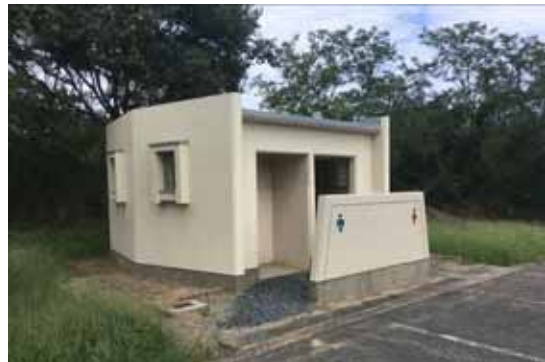
公共駐車場のトイレ・水回りはニーズが高いものの洋式化などが遅れている
