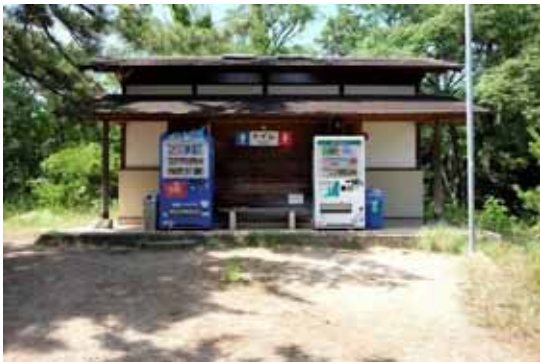
柳茶屋キャンプ場のトイレ 建築外観に合わせた自動販売機の修景が必要である
