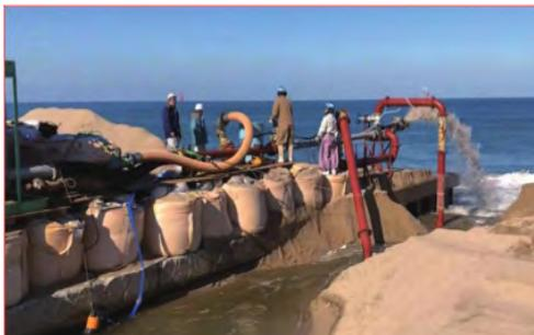
図6 エジェクターによる開削状況
