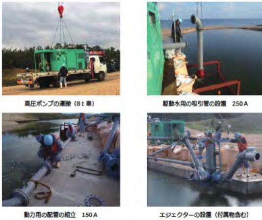
図5 エジェクターシステム実証実験の状況
